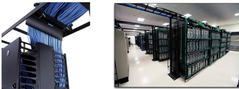
Figura 10 – Os racks receberão o cabeamento horizontal por eletrocalha superior.
