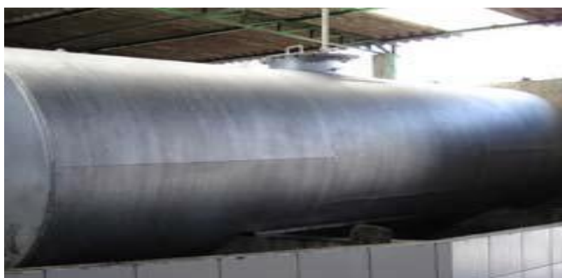
Figura 12: Tanque horizontal em bacia de contenção Fonte: Sohn (2007)
