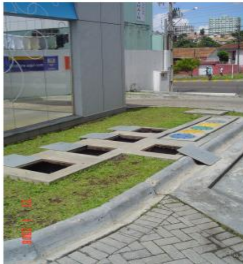
Figura 7: Caixa Separadora de Água e Óleo Fonte: Barros (2006)
