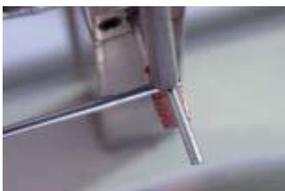
Figura 10 - Soldagem de duas hastes de fio telescópico
