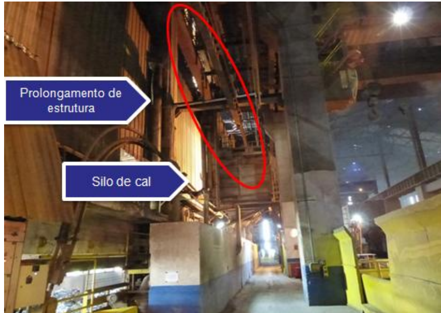
Figura 37. Prolongamento de vigas entre pontes.
