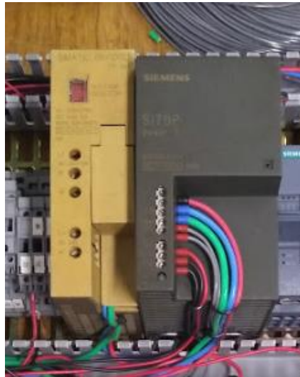
Figura 59 - Fontes de Alimentação IHM e CLP Respectivamente
